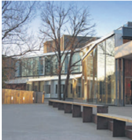
Time, Mixed People' a l'espai Mercè Sala de TMB, ubicat als passadissos de l'estació de Metro Diagonal, i que
