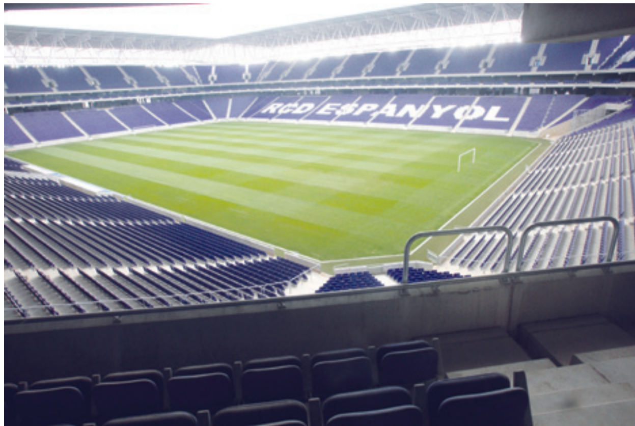
Nou estadi de l'Espanyol a Cornellà
